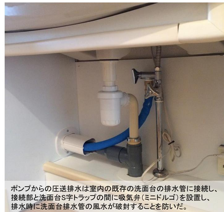
ポンプからの圧送排水は室内の既存の洗面台の排水管に接続し、接続部と洗面台S字トラップの間に吸気弁(ミニドルゴ)を設置し、排水時に洗面台排水管の風水が破封することを防いだ。
